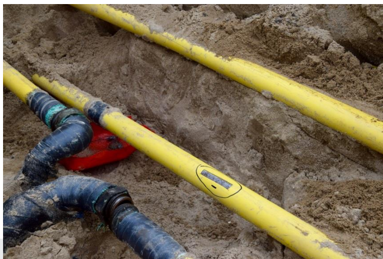
Foto: voorbeeld leidingwerk tank
